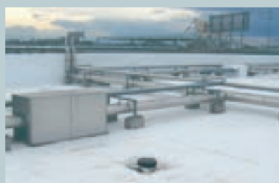
4 La copertura nella zona dove è posizionato l'impianto di climatizzazione.
