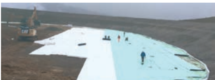
6 Lavori di posa del manto MAPEPLAN T WT sulle sponde e sul fondo del bacino.
