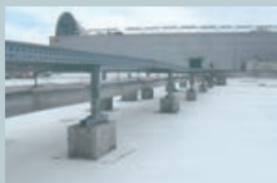
2 La posa del manto MAPEPLAN T M.
