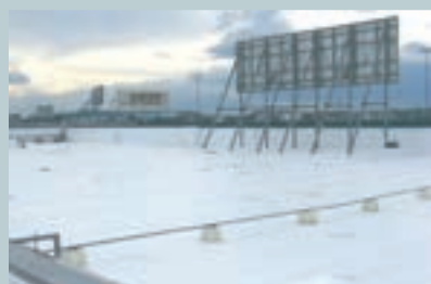
3 La copertura del centro commerciale in prossimità dell'insegna.
