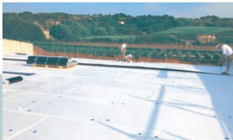
I lavori di copertura dell'edificio: il manto impermeabile ha un'aspettativa di vita di molti decenni come dimostrano i test di invecchiamento accelerato
