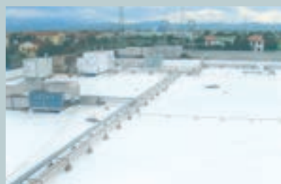
5 La copertura del centro commerciale a lavori ultimati.
