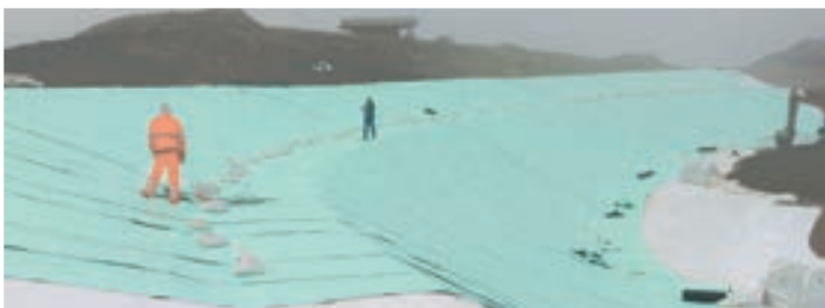
5 Lavori di posa del manto MAPEPLAN T WT sulle sponde e sul fondo del bacino.
